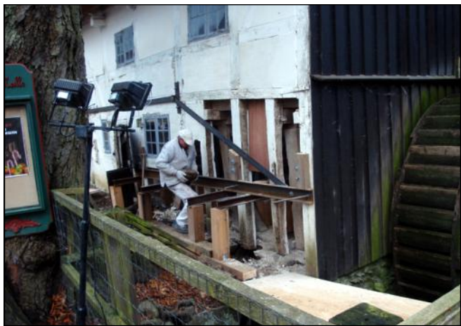
Indsatsen for at understøtte selve møllehuset var en teknisk bedrift
