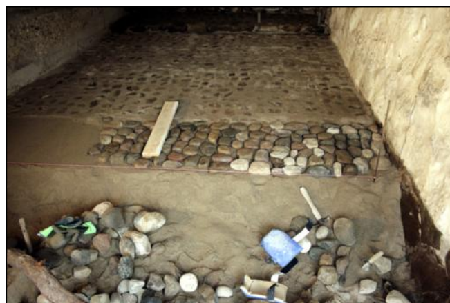
Renovering af gulvet i den gamle vognport. Rodstumpen, der omtales i artiklen, forrest til venstre
