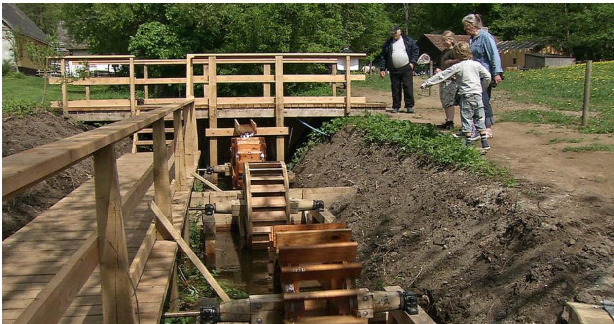
Vandenergianlægget under opførelse. Maj 2010
