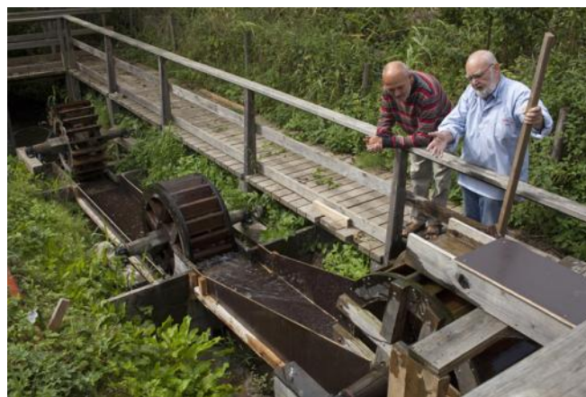
Tre vandhjul med kanaler - ændring i juli 2012
