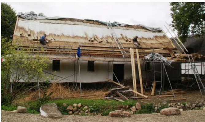
Østsiden af staldene under tækning
