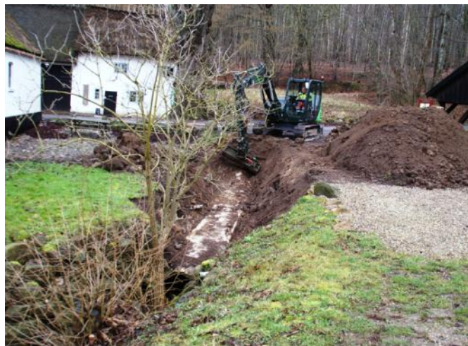
Det støbte rør ses midt i billedet
