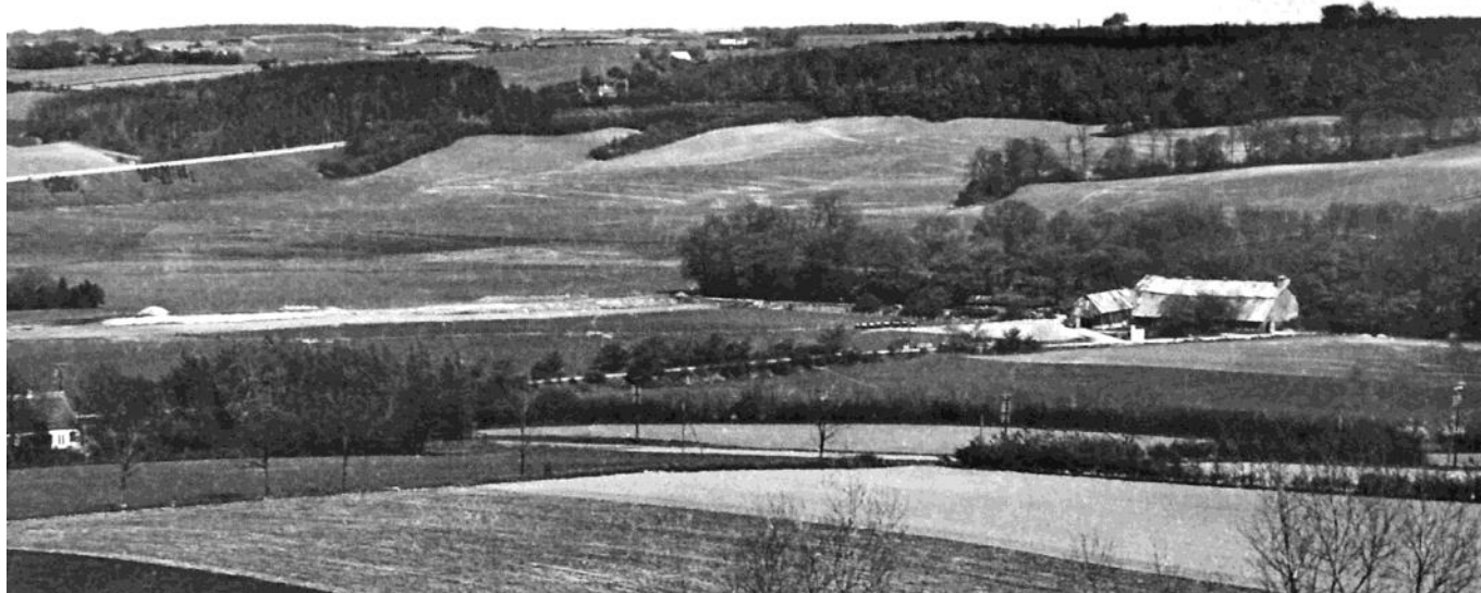
Kalkværket i landskabet sidst i 1930'erne. Bemærk den nyanlagte vejdæmning til hovedvejen over Elverdamsdalen
