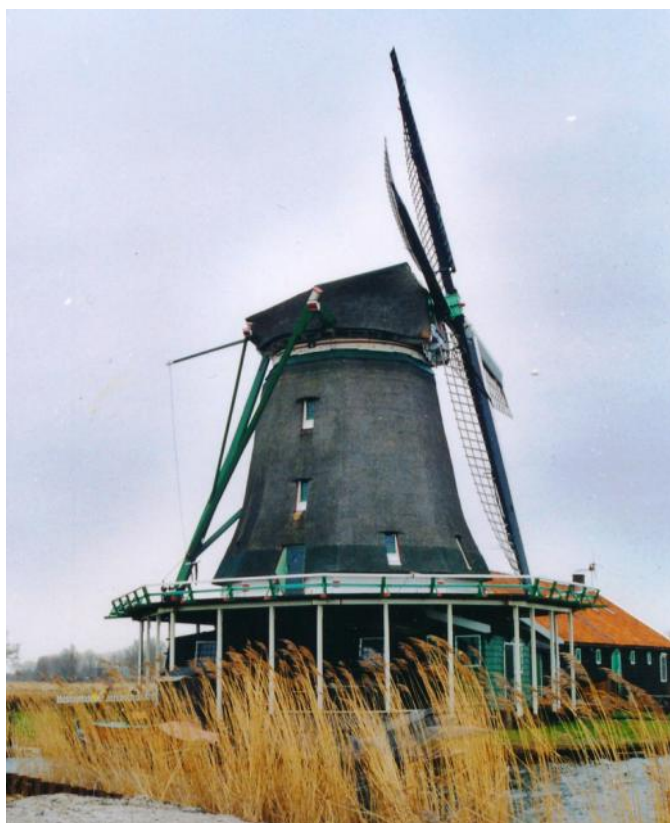
Den store mølle ved kanalen i Zandaam i Holland pumper vand op
