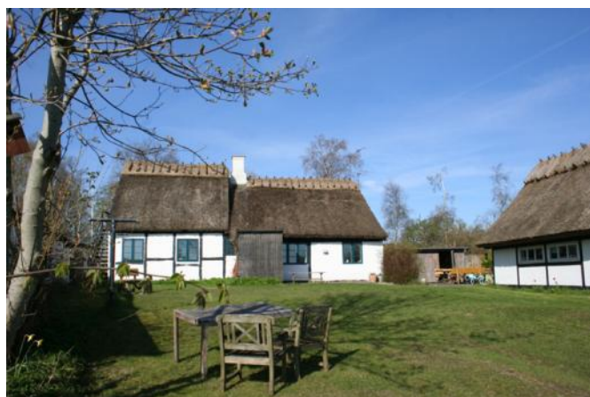
Huset fra havesiden
