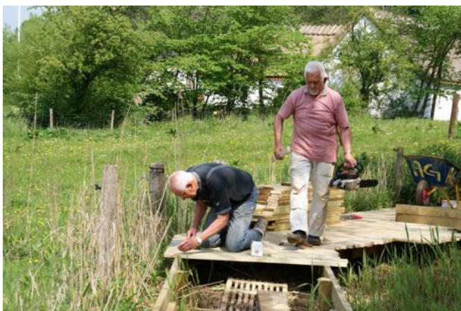
Thorkild og Frederik bygger bro
