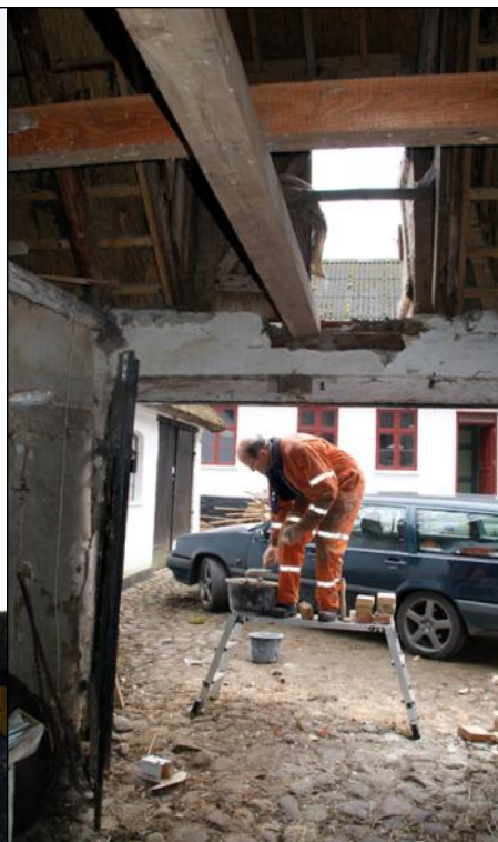
Bærende loftsbjælke udskiftes
