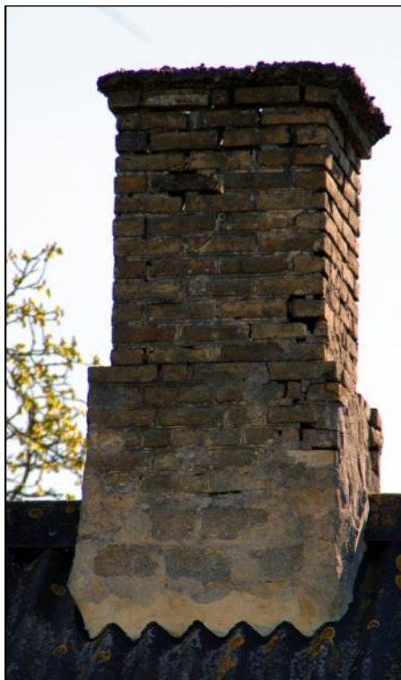
Skorstenen skal renoveres
