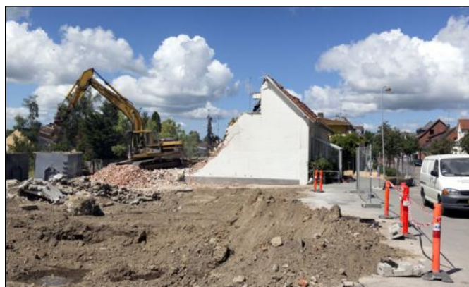
Fra nedrivningerne. Foto Ole Malling
