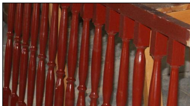
Gelænderet til kælderen er genskabt
