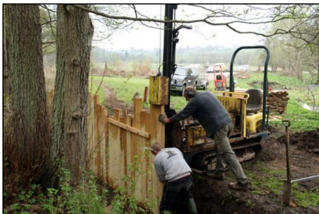
Ny spunsvæg etableres
